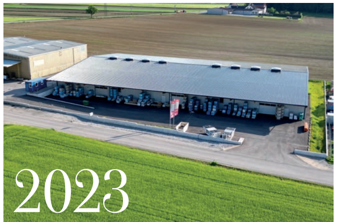
Neubau und Erweiterung der Lagerhalle in Pyhra.
